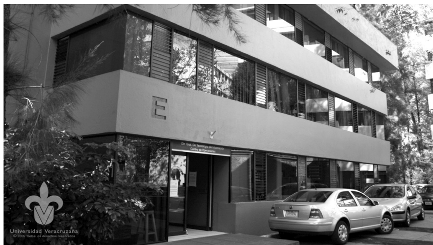
Foto 22. Edificio E. Dirección General de Tecnologías de Información. Fotografía de la DGTI.
