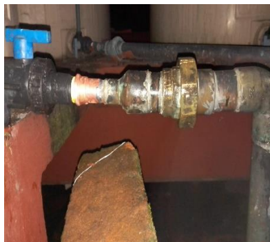
Imagen 133. Suministro y colocación de tubería de tinaco en área trasera del edificio "D". Fuente: Archivo Dirección FAUV Xalapa (2024).
