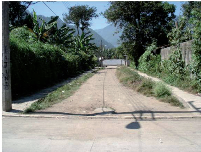
Figura 2. Falta de cobertura en los servicios públicos en Rafael Delgado
