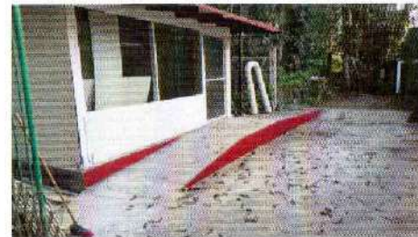
Pintura de nuevo salón.
