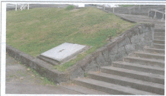
F2: Cuarto de Bombas
