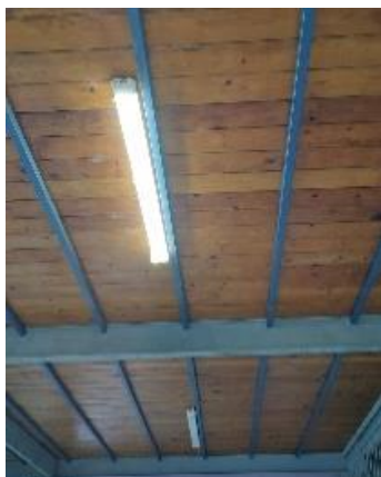
Figura 27. Sistemas de ahorro energético con sensores de movimiento en los pasillos comunes de la UICQ
