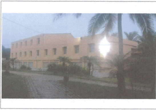
F1: Edificio "C" Contaduría
