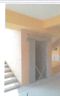
F5: cubo de elevador 1er nivel.
