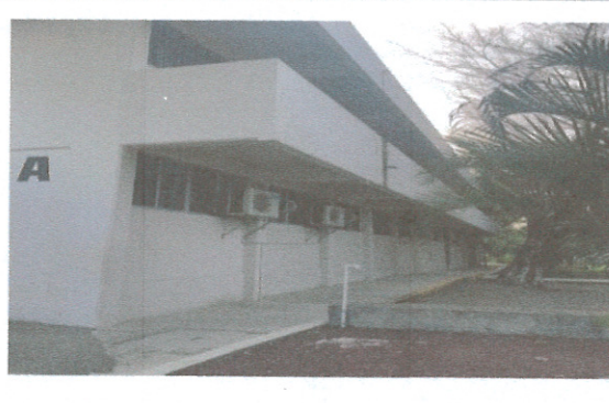
F4: Edificio A
