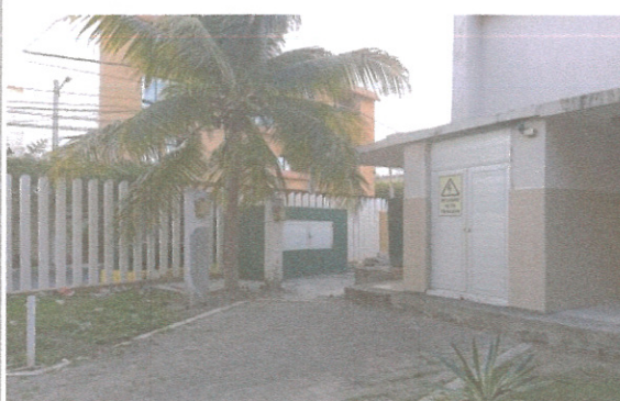
F4: Barras derivadoras ya terminadas y operando.
