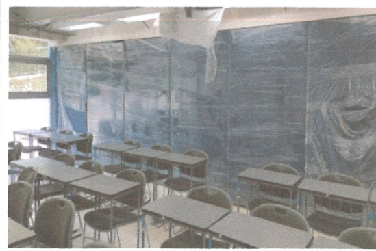
F4: Edificio D, aulas híbridas (sonomuros)
