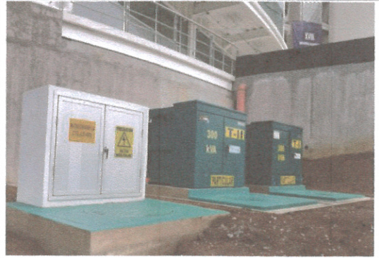
F1: Edificio (B) Entrada principal
