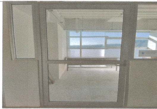
F2: Cubículos último nivel Edificio B
