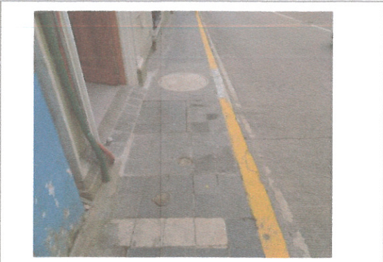
F3: Registro de media tensión en acceso principal
