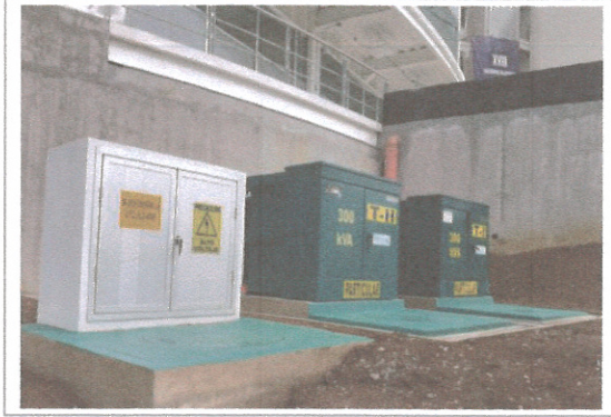
F1: Edificio (B) Entrada principal
