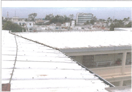
F3: Cubierta multipanel ya reparada y colocada vista desde la cubierta misma.
