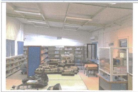
F1: Fotografía tomada desde el interior de la biblioteca donde se observa la cubierta y el piso ya terminado, se observa que la facultad ya comenzó a utilizar el área que se intervino.
