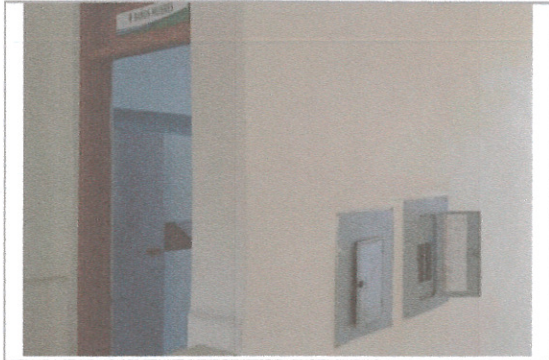
Fotografía F1: Tableros ubicados a un costado del baño de mujeres en segundo nivel.
