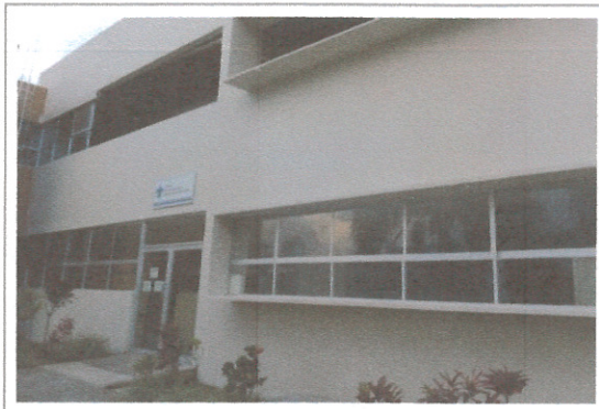
F1: Fachada principal
