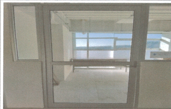
F2: Cubículos último nivel Edificio B
