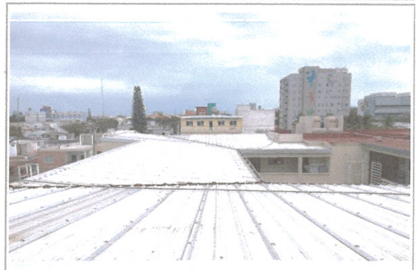
F5: Cubierta multipanel ya reparada y colocada vista desde la cubierta misma.
