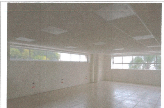
F4: Vista general primer nivel Posgrados
