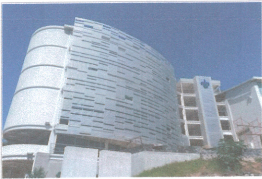
F1: EDIFICIO B VISTA DERECHA
