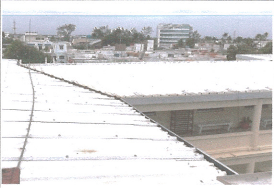
F3: Cubierta multipanel ya reparada y colocada vista desde la cubierta misma.
