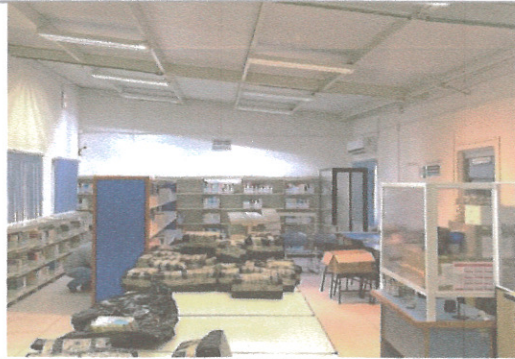
F1: Fotografía tomada desde el interior de la biblioteca donde se observa la cubierta y el piso ya terminado, se observa que la facultad ya comenzó a utilizar el área que se intervino.
