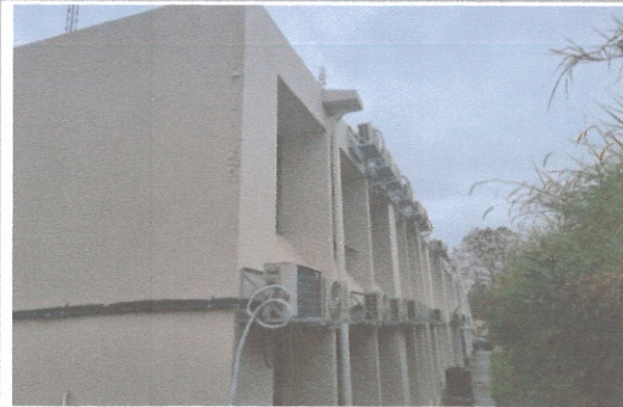
F2: fachada posterior
