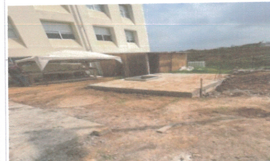
F5: VISTA DE ÁREA DE CISTERNA PLUVIAL
