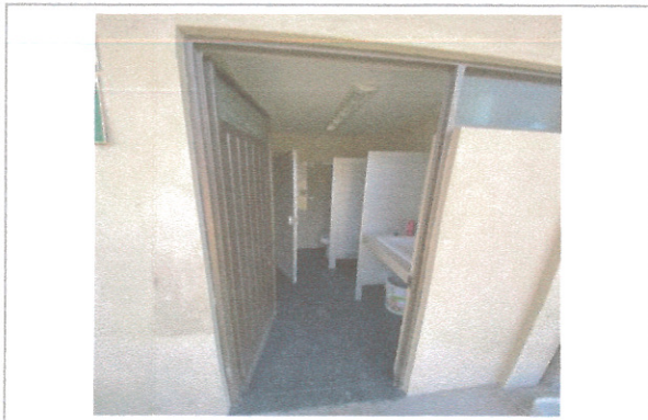
F4: Baño en zona de talleres
