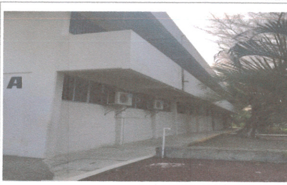
F4: Edificio A
