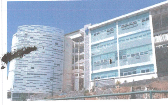
F4: VISTA DE FACHADA
