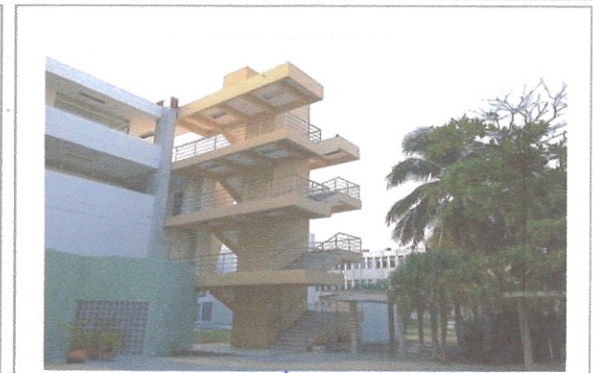
FOTO 5: ESCALERAS DEL EDIFICIO "B"
