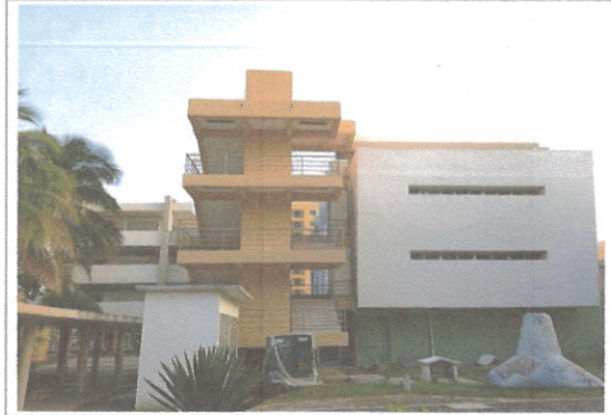
F1: ESCALERAS DEL EDIFICIO "B"
