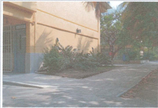
F1: Rampas Exteriores
