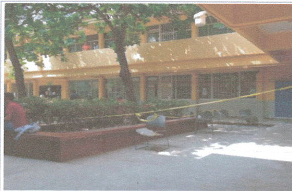
F2: Rampas Exteriores
