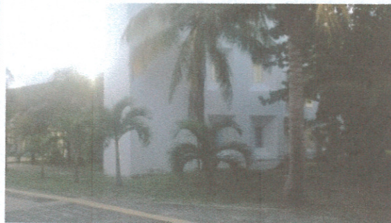
F4: Edificio Instituto de Ingeniería
