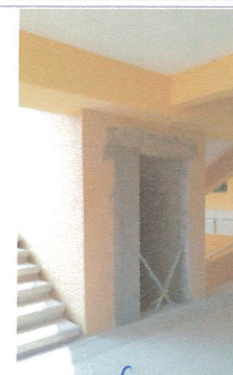
F5: cubo de elevador 1er nivel.
