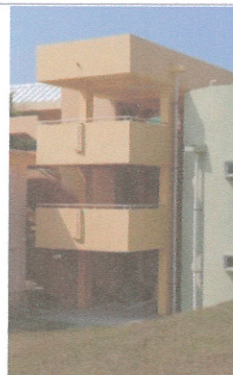
F4: Cubo de elevador y pasillos de circulación
