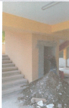
F3: cubo de elevador Planta baja.
