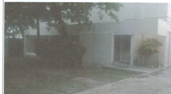
F5: Edificio SEA
