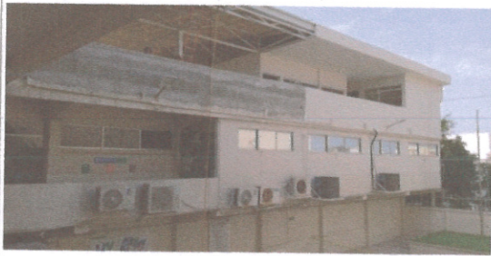
F1: Fotografía tomada desde el primer nivel del Edificio C, se observa los trabajos ya terminados.
