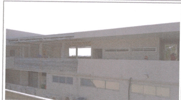
F5: Fotografía tomada desde el segundo nivel del Edificio C, se observa los trabajos ya terminados.
