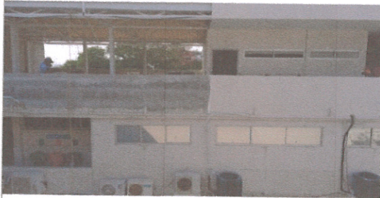
F3: Fotografía tomada desde el segundo nivel del Edificio C donde se observa los trabajos ya terminados.
