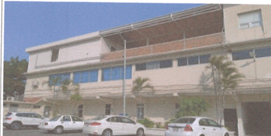
F4: Fotografía tomada a nivel del suelo desde el estacionamiento de la facultad, se observa los trabajos ya terminados.
