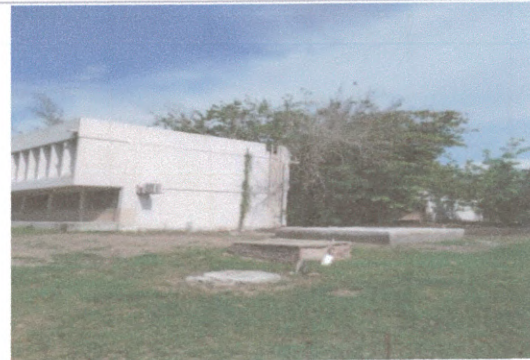
F2: Edificio G y E
