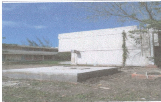
F4: Edificio E
