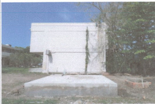
F3: Edificio E
