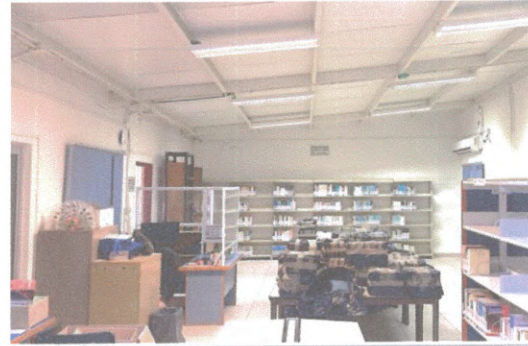
F2: Fotografía tomada desde el interior de la biblioteca donde se observa la cubierta y el piso ya terminado, se observa que la facultad ya comenzó a utilizar el área que se intervino.
