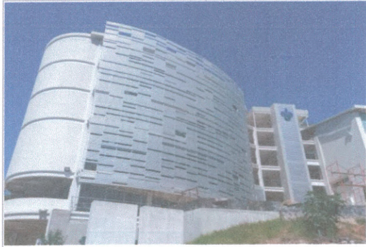
F1: EDIFICIO B VISTA DERECHA
