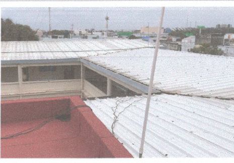
F4: Cubierta multipanel ya reparada y colocada vista desde la cubierta misma.
