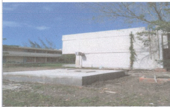
F4: Edificio E
