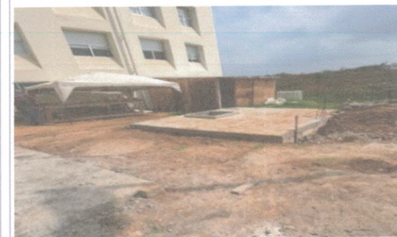
F5: VISTA DE AREA DE CISTERNA PLUVIAL
