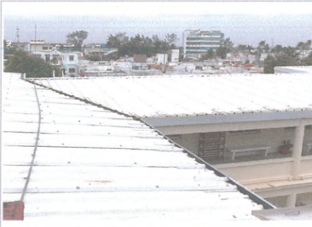
F3: Cubierta multipanel ya reparada y colocada vista desde la cubierta misma.
