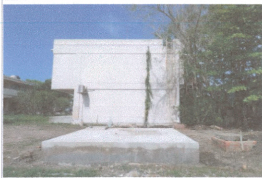
F3: Edificio E
