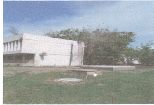
F2: Edificio G y E
