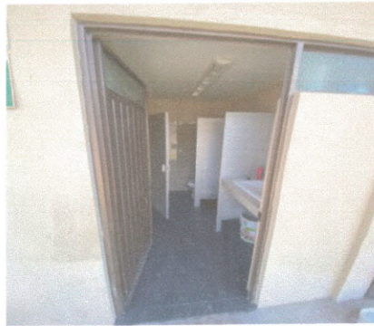
F4: Baño en zona de talleres
