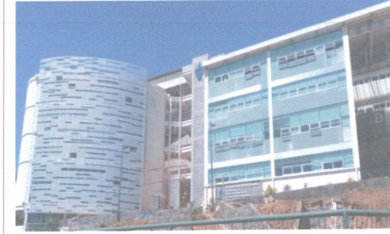
F4: VISTA DE FACHADA
