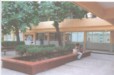
F2: Rampas Exteriores
