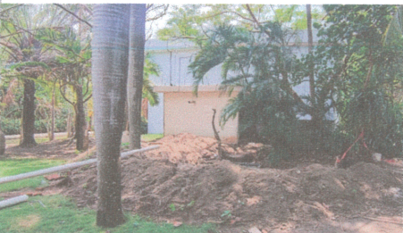
F3: Cisterna ubicada en la Vicerectoría
