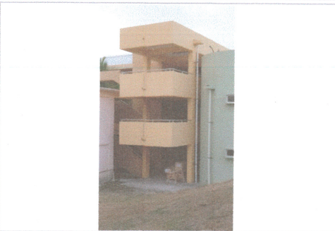
F4: Cubo de elevador y pasillos de circulación
