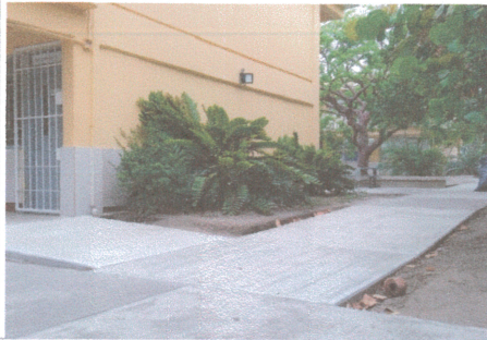
F1: Rampas Exteriores
