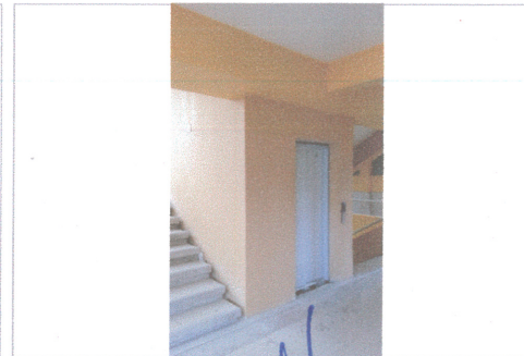
F5: cubo de elevador 2er nivel.
