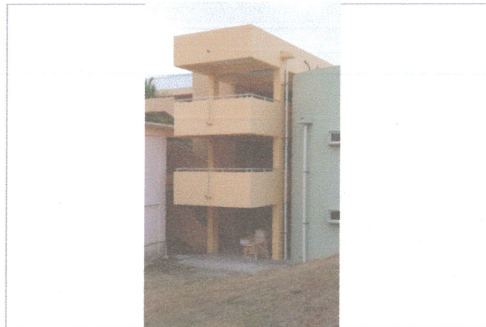
F4: Cubo de elevador y pasillos de circulación
