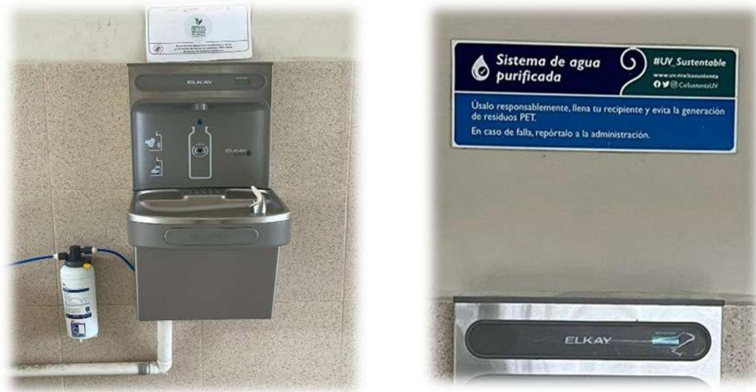
Figura 81.- Bebederos instalados en la FCByA con señalización del sistema de agua purificada
