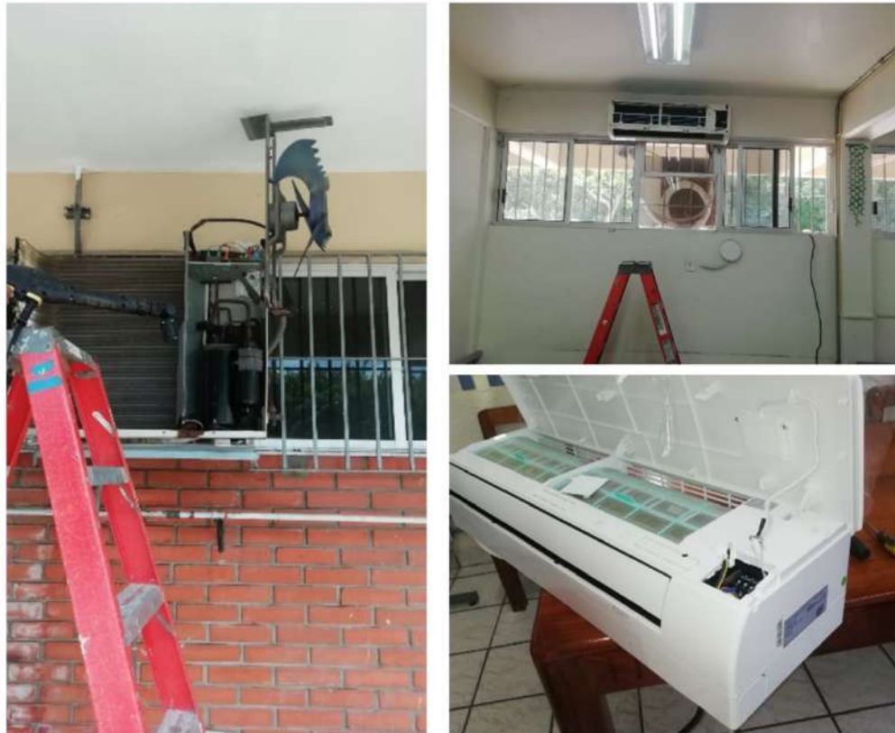
Figura 71. Mantenimiento e instalación de equipos acondicionadores de aire para los diferentes espacios de la Facultad.
