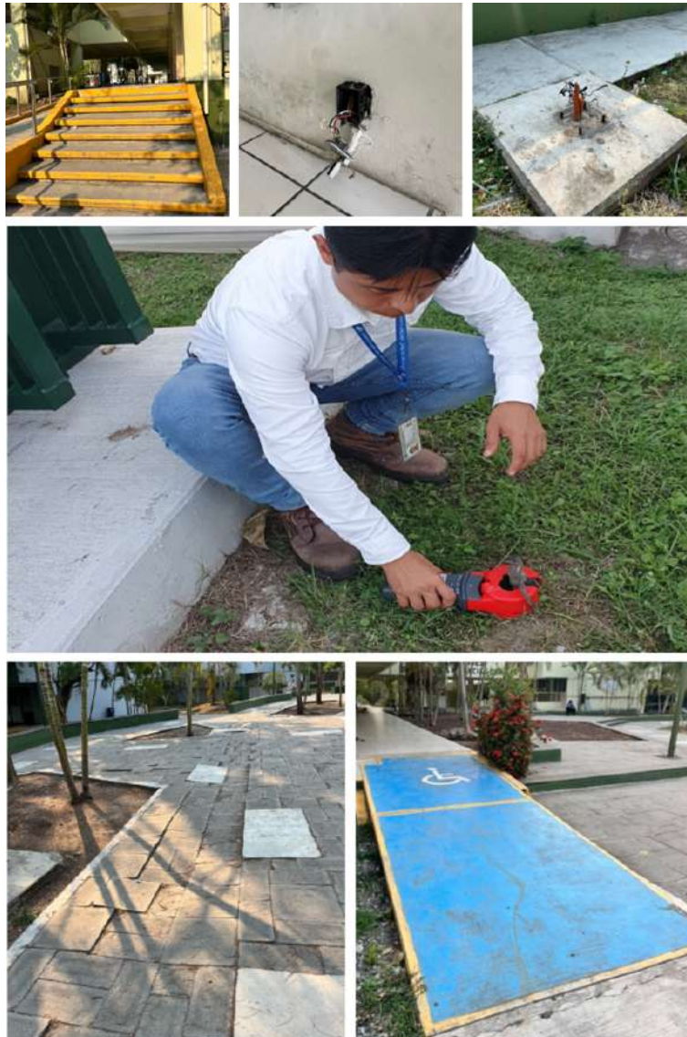
Figura 13. Análisis de riesgo en las instalaciones de la entidad
