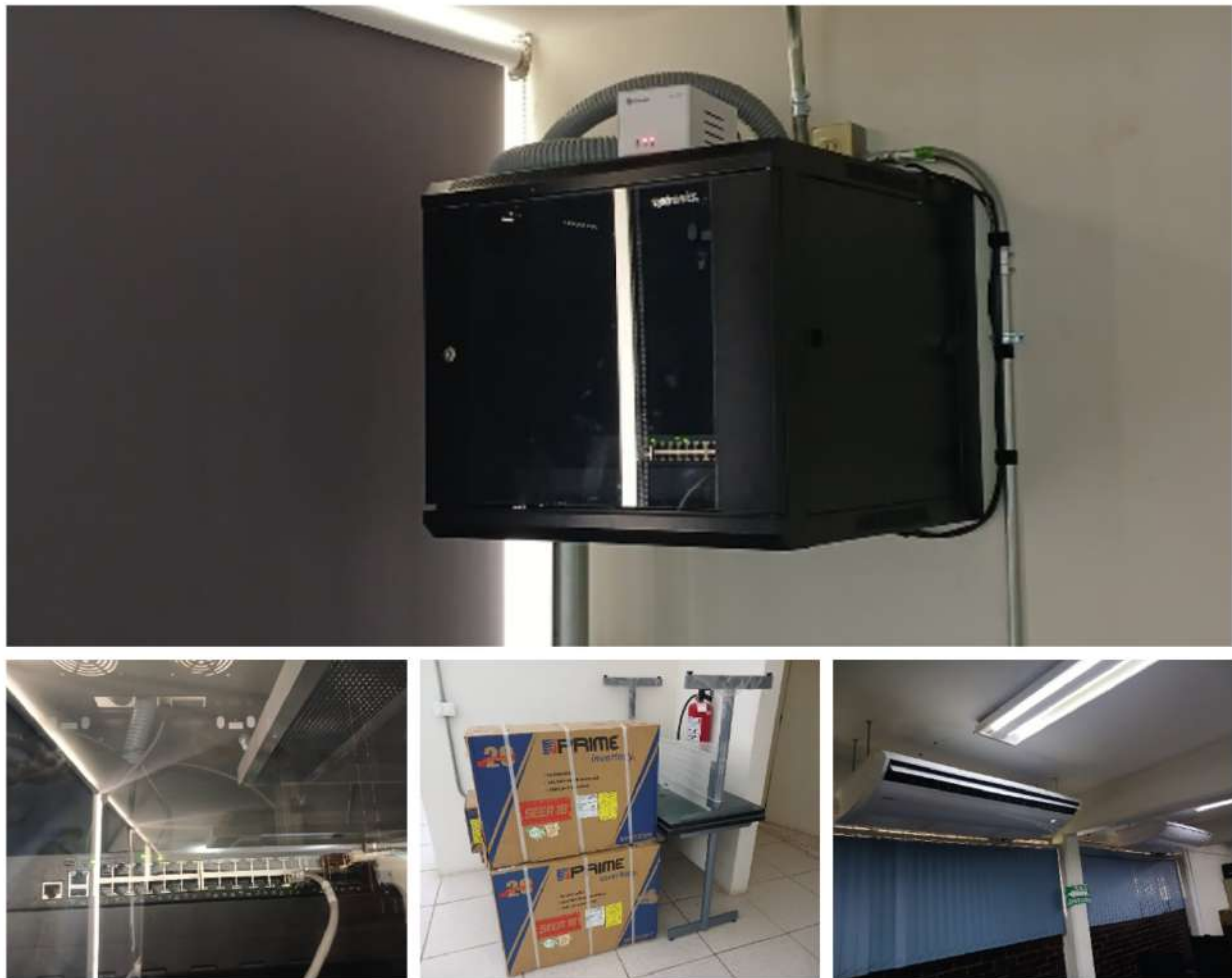
Figura 70. Nuevo gabinete y swicht de red para el edificio E.
