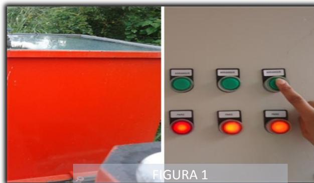
2. Encienda la bomba No. 1 de coagulante por 20 min para homogenizar). Figura 2
