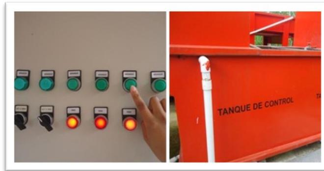
10. Asegúrese que halla una buena reacción de los canales de sedimentación, una vez que el agua comience a caer al canal de distribución, regular las válvulas del tanque de recepción y de tanque de control manera de mantener el nivel en el canal de distribución y el tanque de control
