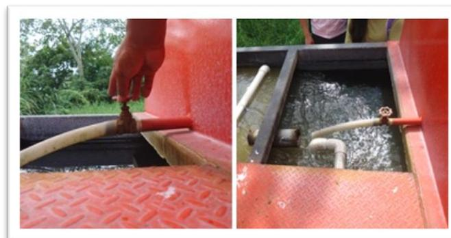
9. Encender la bomba no. 5 de envío del tanque de control una vez que el nivel del tanque este alrededor de los 40cm Figura 9
