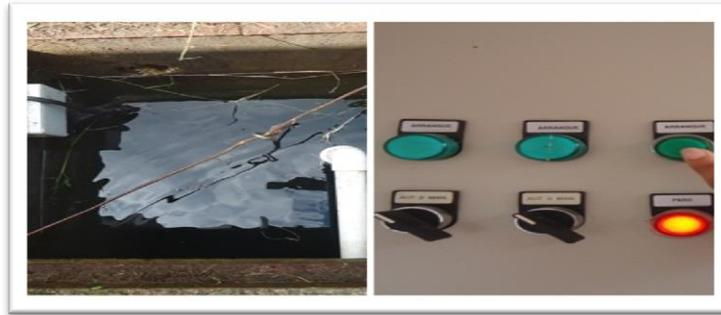
7. Cuando el nivel del tanque este alrededor de los 40 cm encender la bomba no. 4 del tanque de recepción. Figura 7
