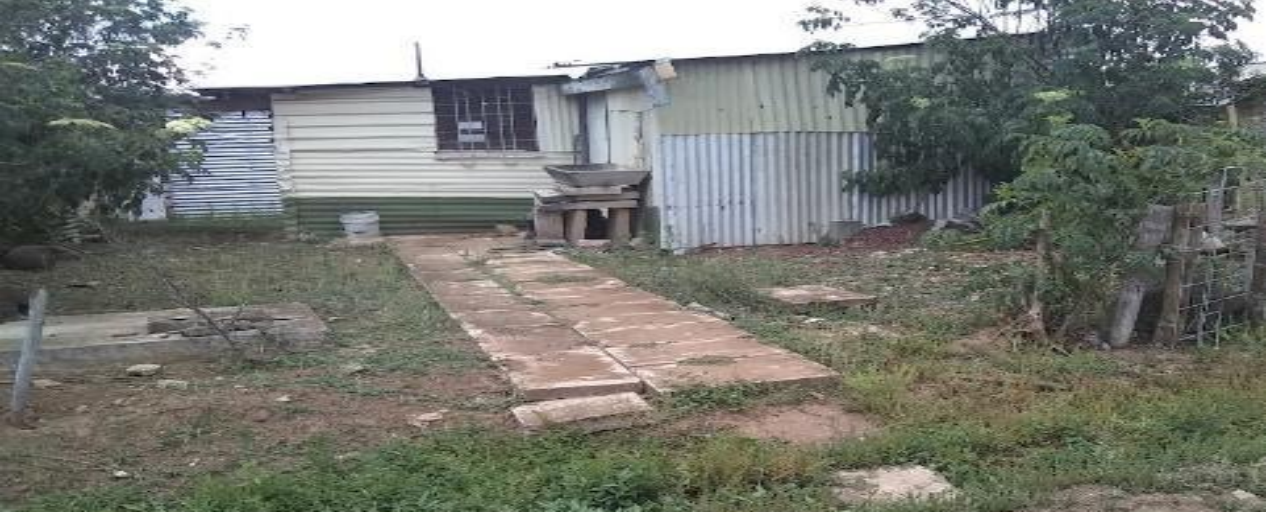
Imagen 15: Vivienda improvisada con materiales precarios
