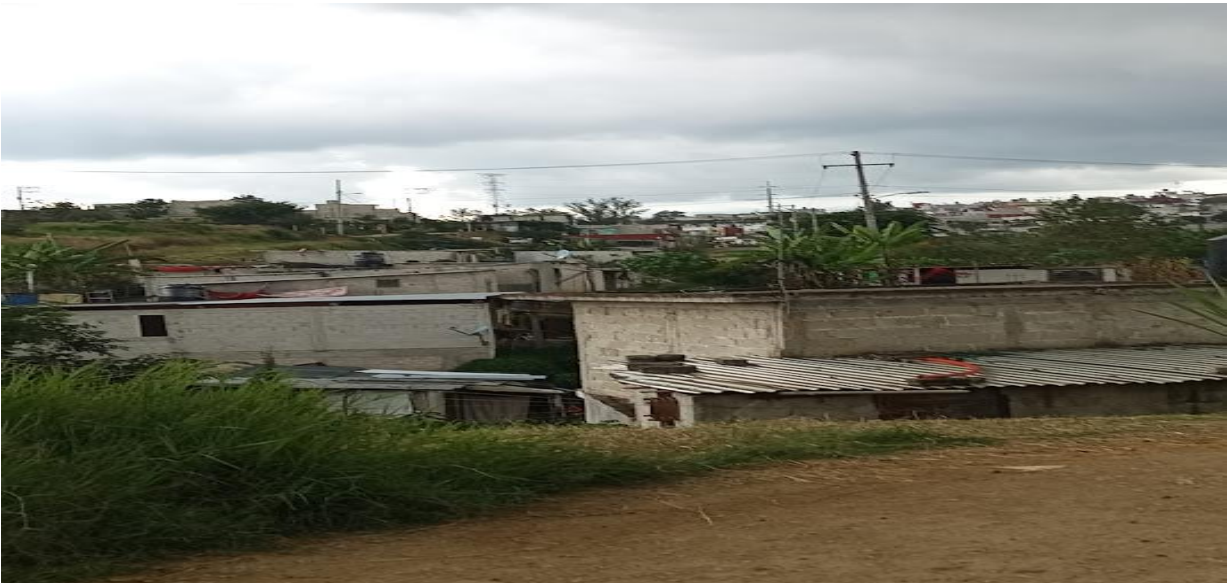
Imagen 14: Viviendas precarias de los habitantes en la colonia 6 de junio
