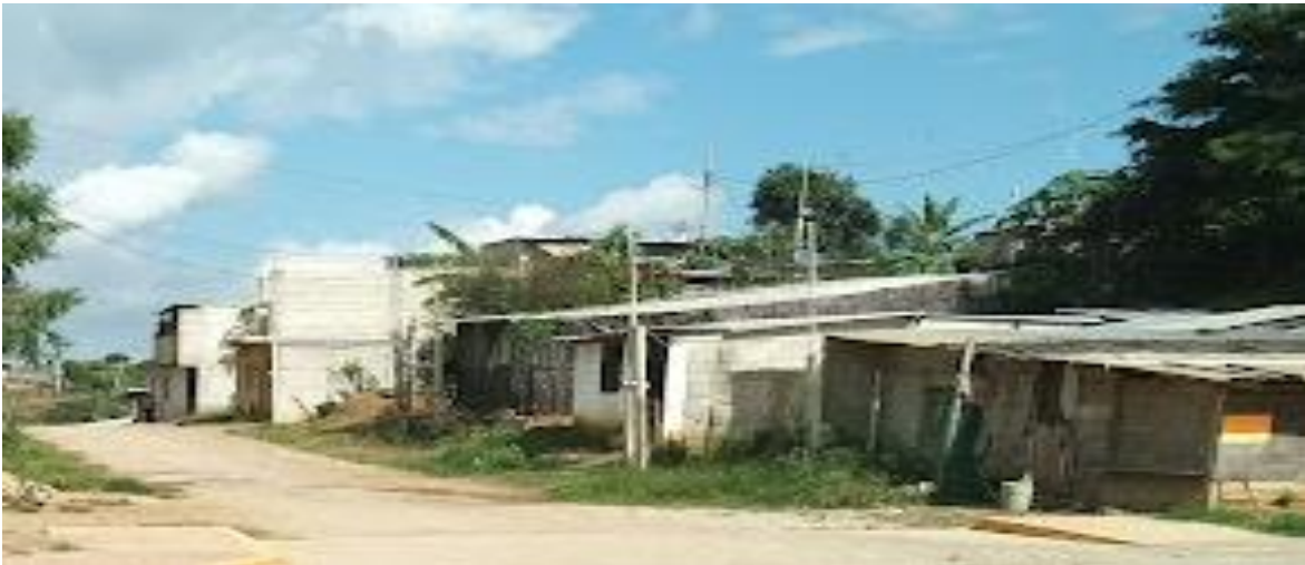
Imagen 16: Construcción física de viviendas precarias por parte de los habitantes del asentamiento humano
