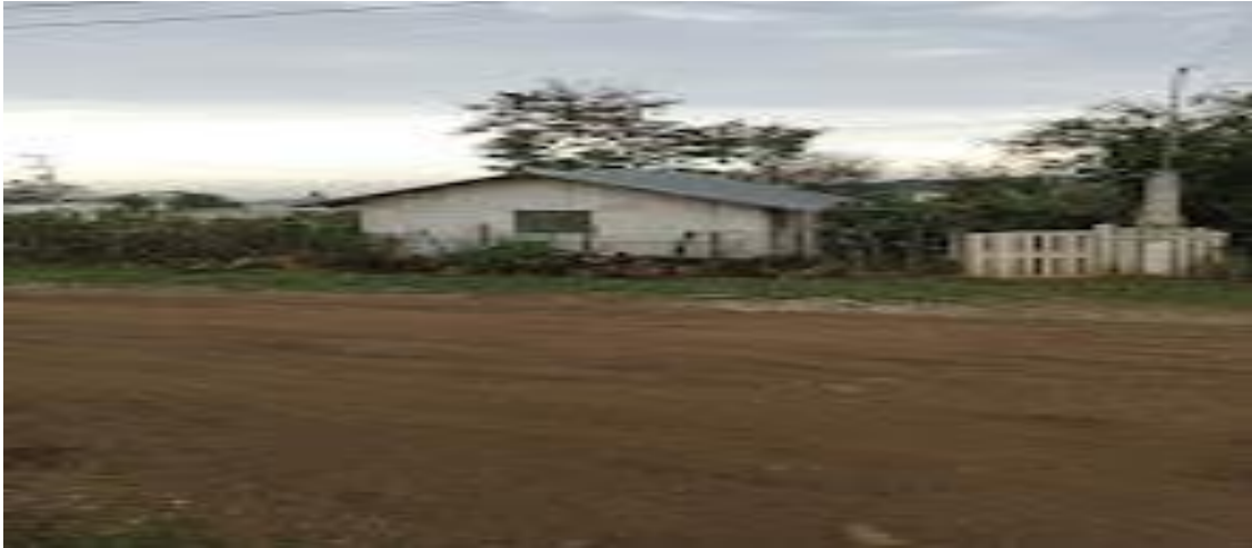
Imagen 13: Materiales de las viviendas construidas
