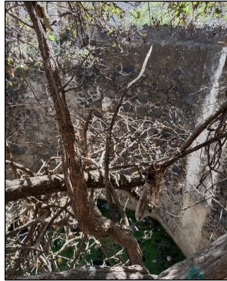
Figura 98. Fotografía, "Pozo" Zavaleta Andrés Mariana 2023
