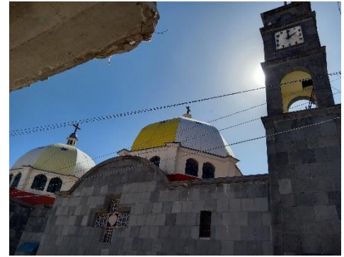
Figura 68. Fotografía, "Capilla de Quecholac" Zavaleta Andrés Mariana 2023
