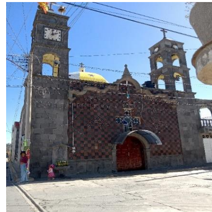
Figura 70. Fotografía, "Capilla de Quecholac" Zavaleta Andrés Mariana 2023
