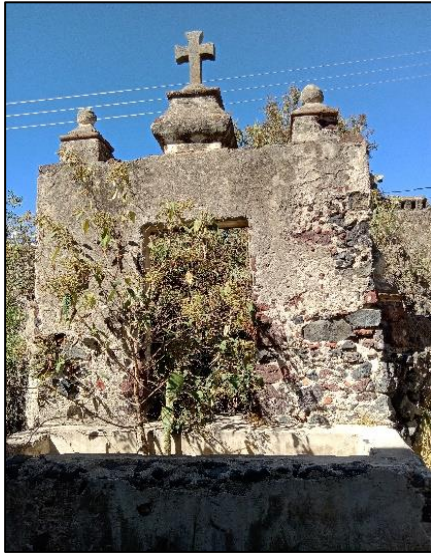
Figura 97. Fotografía, "Pozo" Zavaleta Andrés Mariana 2023
