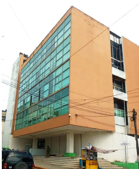
Figura 17. Fachada del edificio de la Sección 10 del S.T.P.R.M.
