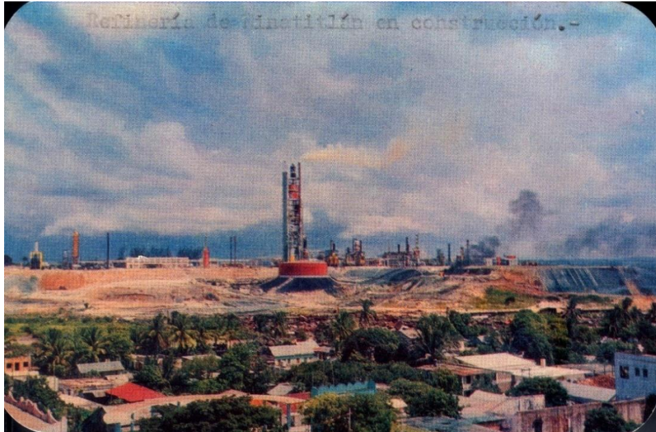
Figura 3. Refinería de Minatitlán en construcción
