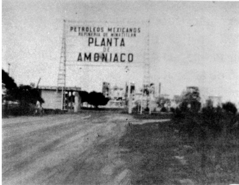
Figura 15. Entrada a la planta de amoniaco, inicio de lo que es hoy el complejo petroquímico Cosoleacaque
