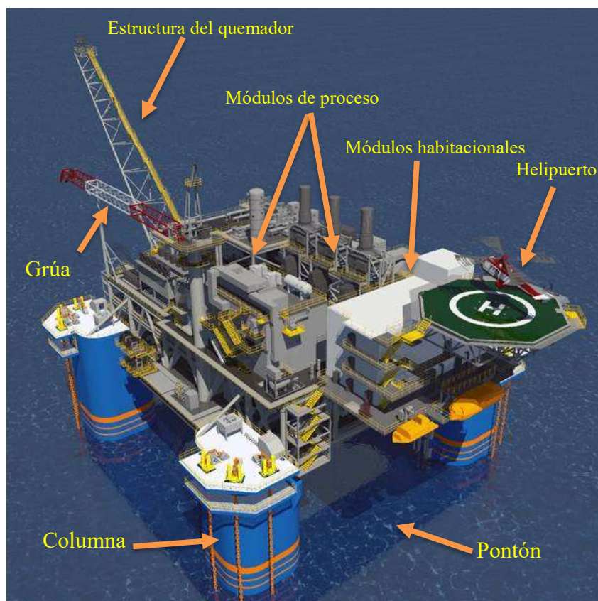
Figura 2.1. Componentes principales de una plataforma semi-sumergible (Pallanich, 2017).
